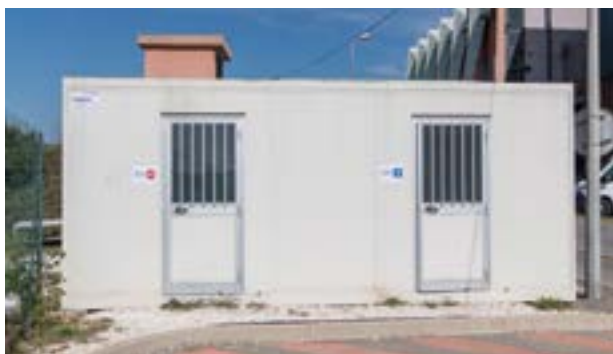
Sas d'entrée de la base vie des entreprises extérieures
